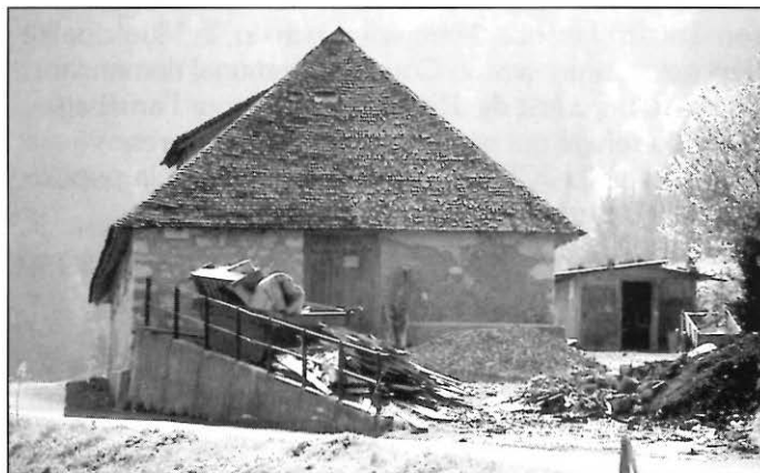
La chalet d'alpage tel qu'il se présentait avant les premiers travaux qui débutèrent le 23 avril 1990.
