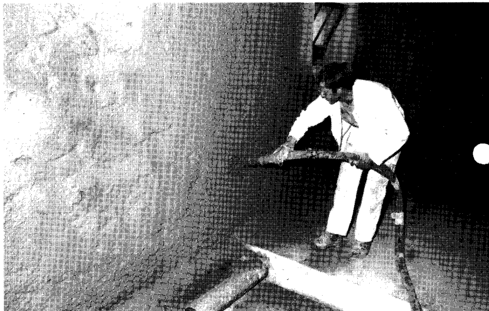
Coulage de la chape de la grande salle... ... et crépissage des murs.
