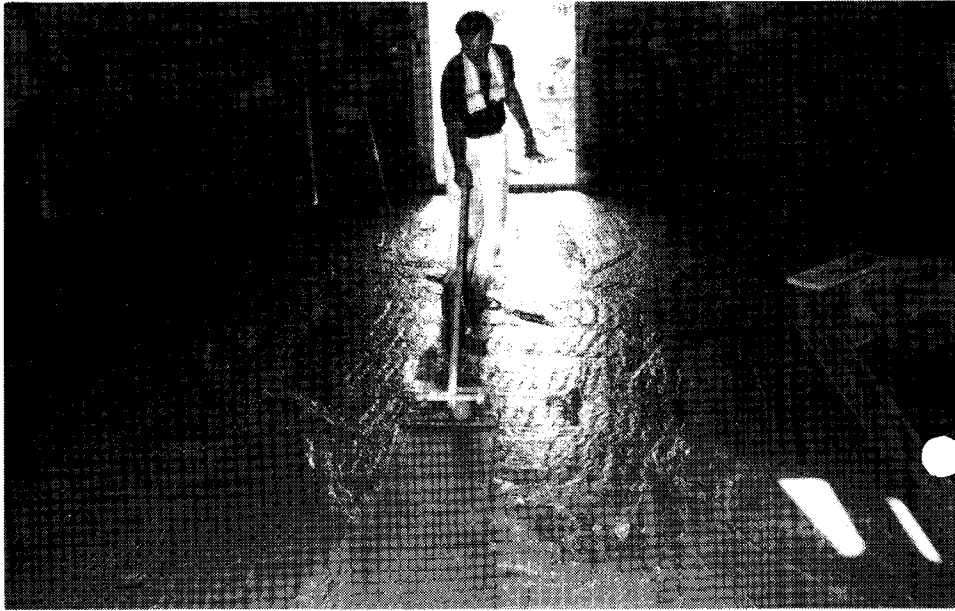
Coulage de la chape de la grande salle... ... et crépissage des murs.
