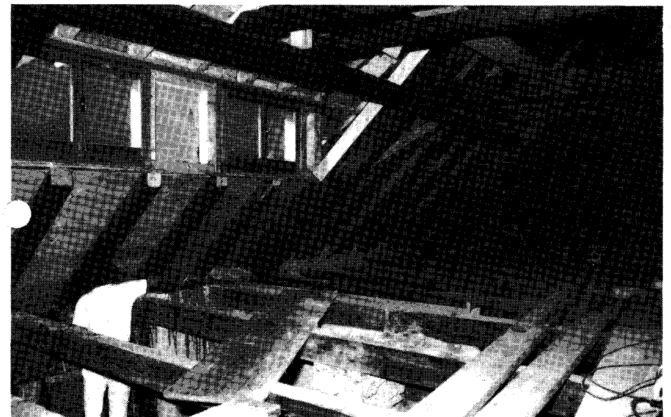
Aménagement des ouvertures dans le toit.
