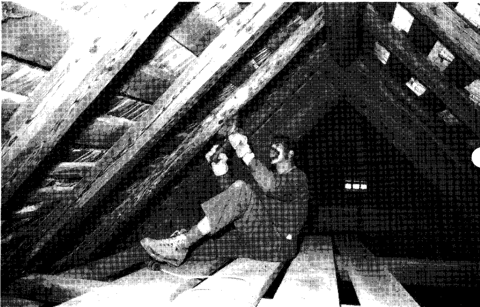
Nettoyage et ponçage des poutres de la charpente.
