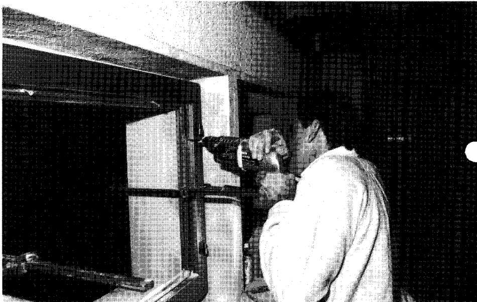
Pose des fenêtres.
